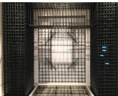
柱箍筋 180 度彎鉤錨定／樑箍筋上蓋 135 度彎鉤／SA 級續接器
