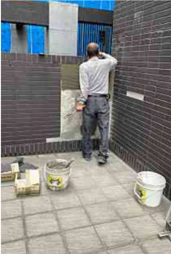
新北市案 - 地震磁磚脫落
