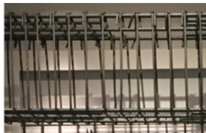
柱箍筋 180 度彎鉤錨定／樑箍筋上蓋 135 度彎鉤／SA 級續接器
