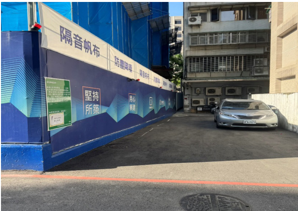
聯上建案工地圍籬、安全防護網及隔音帆布照片
