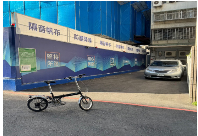
聯上建案工地圍籬、安全防護網及隔音帆布照片
